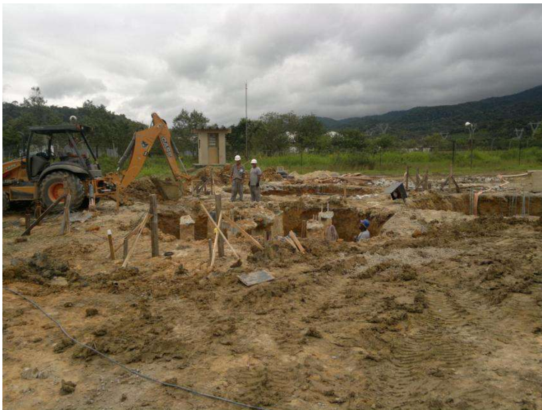
Figura 1 – Trabalhos de arrasamento das estacas da coluna oeste do pórtico sul.
