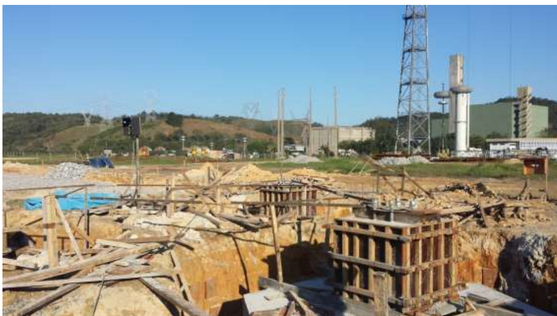
Figura 18 – Concretagem do bloco de fundação dos pórticos.
