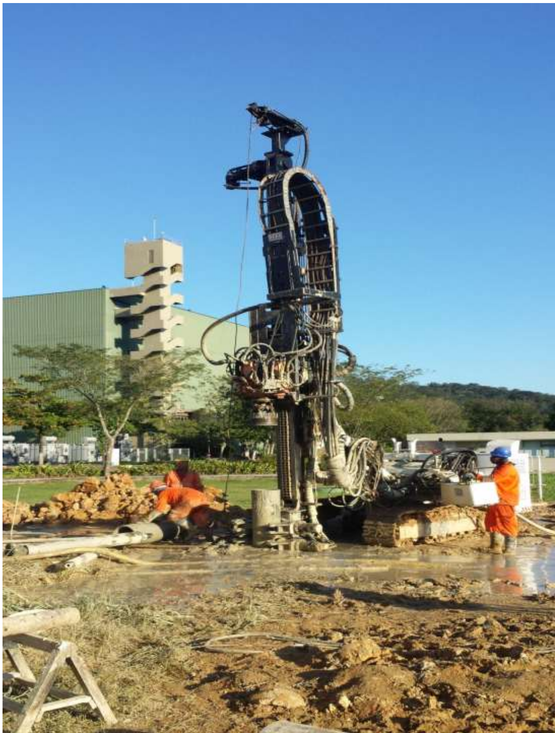
Figura 19 – Perfuração das estacas raiz das fundações dos pórticos.
