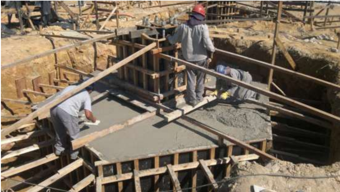
Figura 4 – Concretagem das bases das colunas leste do pórtico Norte.
