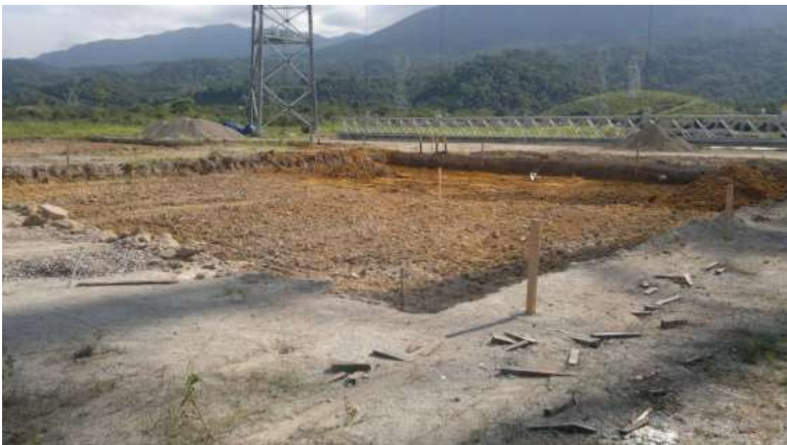
Figura 5 - Preparação do terreno para construção de uma das lajes.
