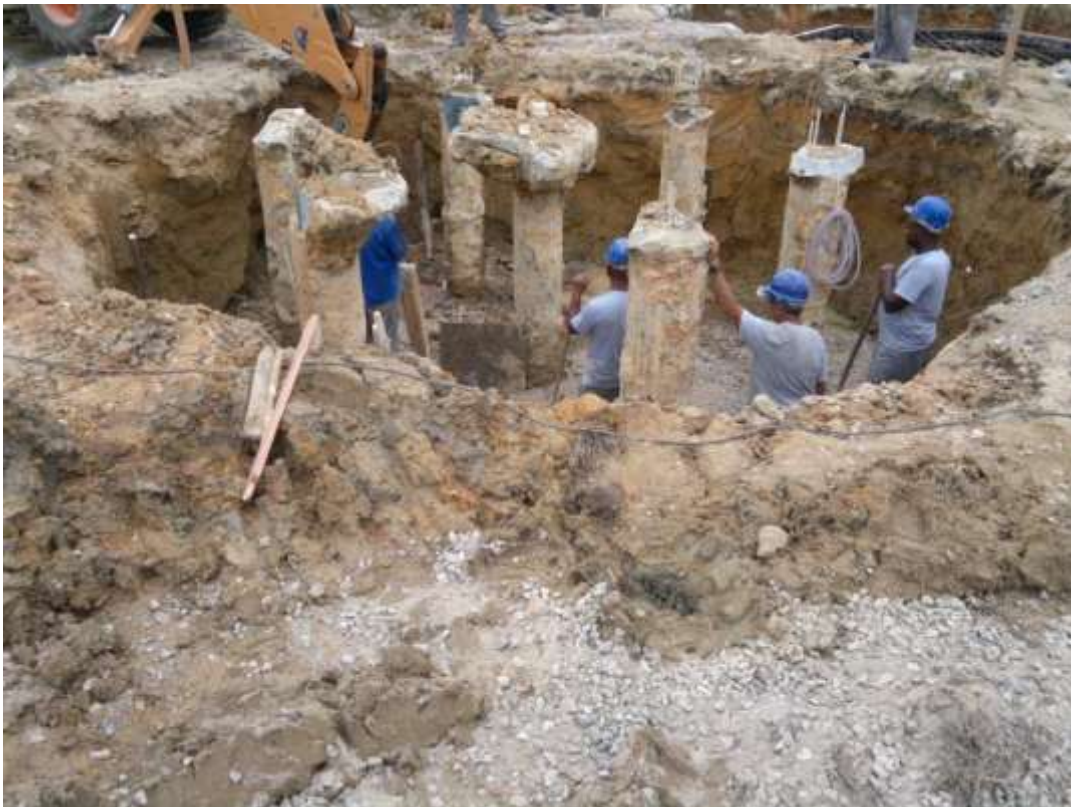
Figura 3 – Trabalhos de arrasamento das estacas da coluna oeste do pórtico sul.
