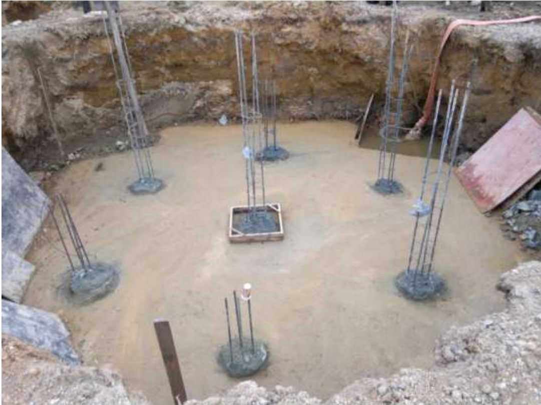
Figura 2 – Preparação para montagem das formas base da coluna oeste do pórtico sul.
