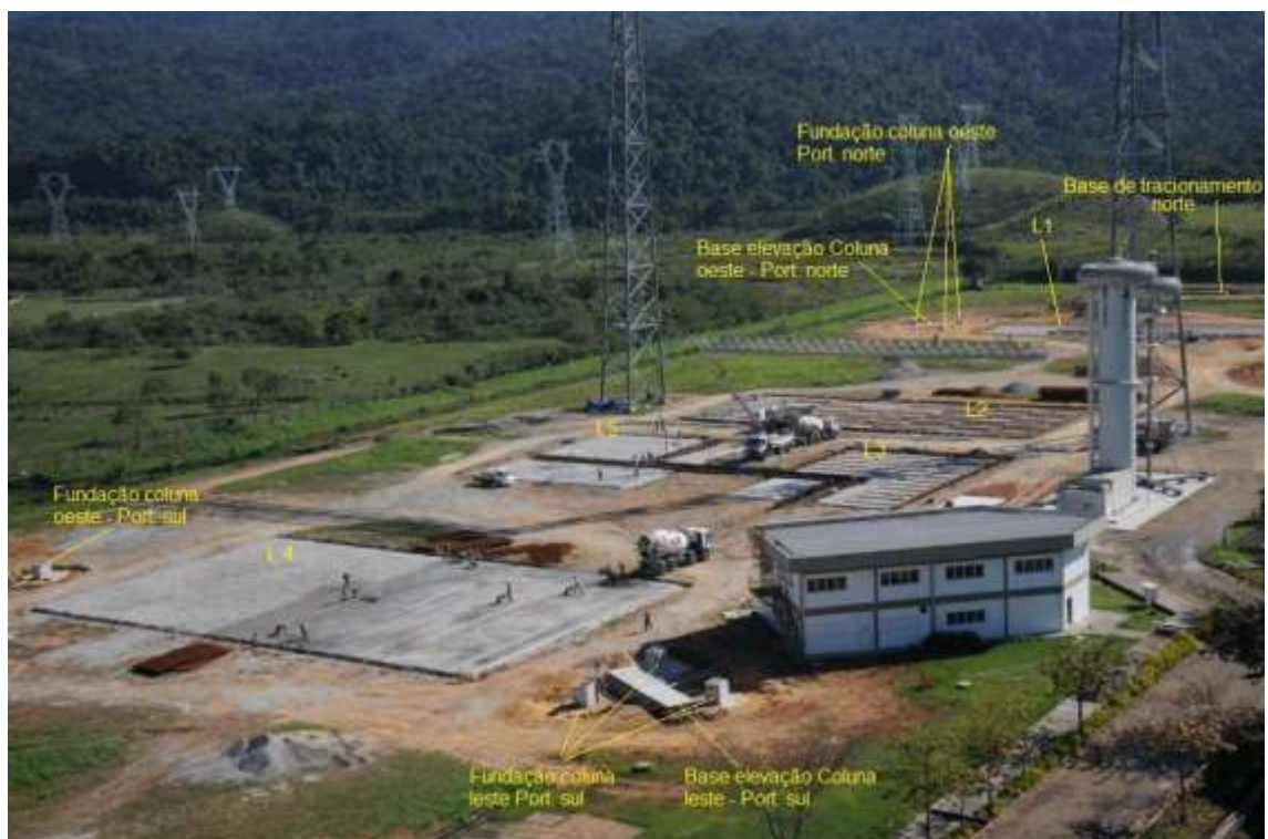
Figura 7 - Vista panorâmica da obra com visualização das lajes, fundações e bases, com legenda.
